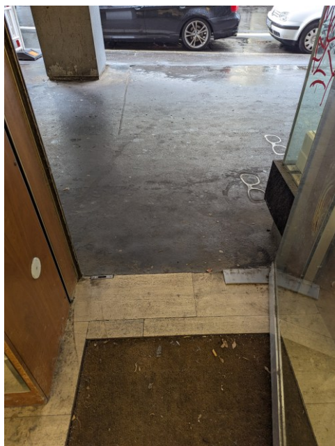
Links: Zutritt Innenraum Hansastr. 26
