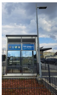
Barrierefreier Zugang vom Parkplatz zum Hauptbahnhof
