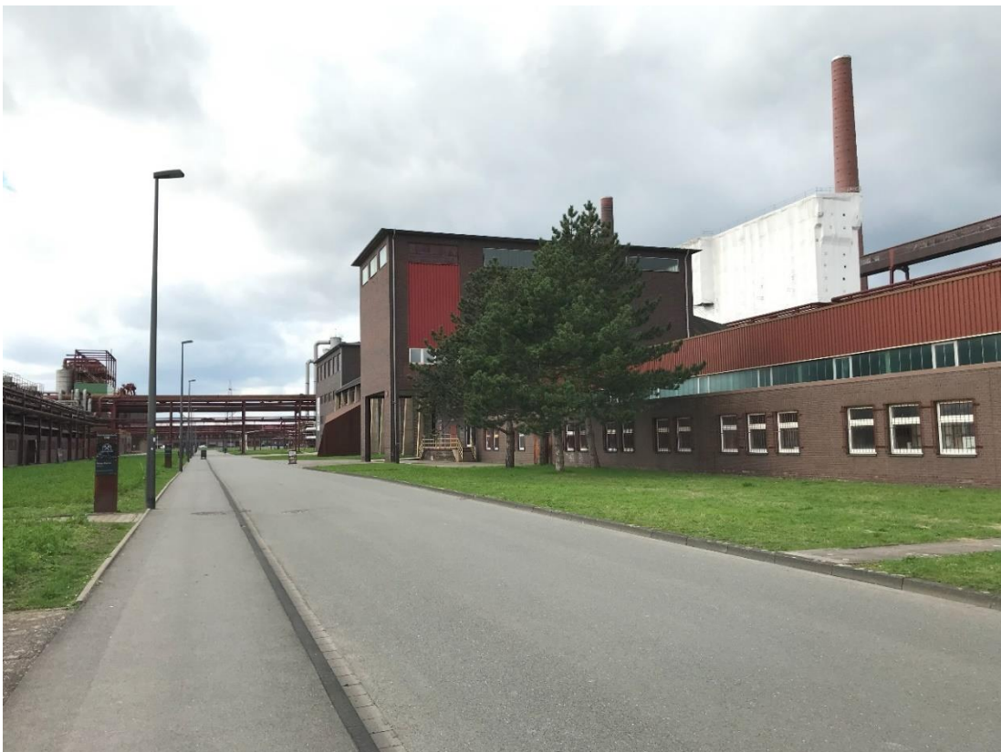
1 Blick Richtung Salzlager vom Gehweg aus
